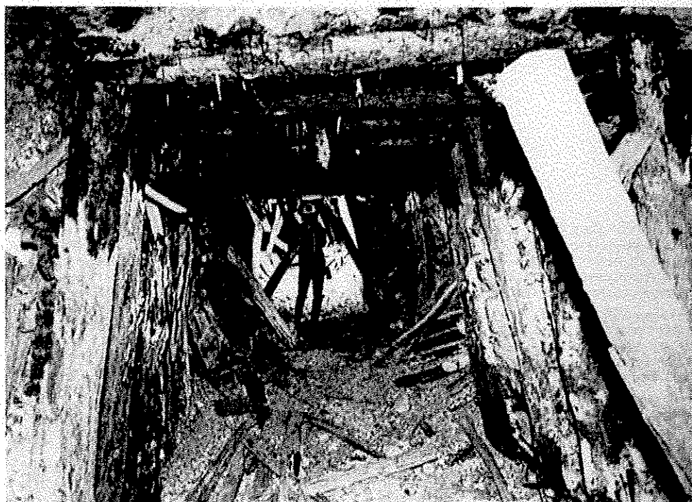
FIGURE 21 - Grande carrière BRILL - Galerie d'entrée (N° 5) boisée - Photo A.N.E.P.A.M. (1985)
