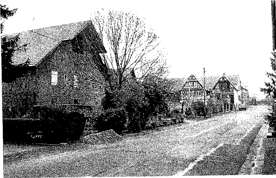
Rue Egerlé Vue en direction du Nord
