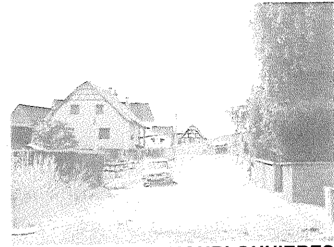
4- vue depuis l'Est de la rue des Houblonnières
