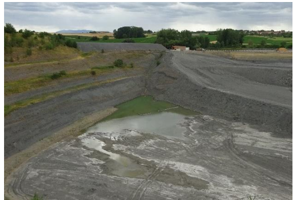
Bassin de fond de fosse en période de basse-eaux
